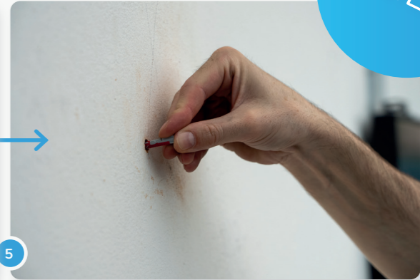
5 ...und stecke dann die Wanddübel hinein.
