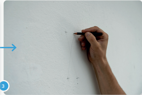
3 Überlege dir, wo du die Profile anbringen wirst, damit diese parallel zueinander an die Wand geschraubt werden können.
