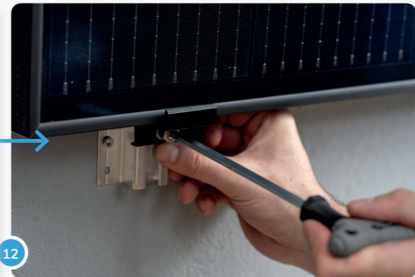
12 Wenn sich die Klemme in der endgültigen Position befindet, kannst du sie mithilfe der Schrauben und eines Drehmomentschlüssels fixieren. (Das richtige Drehmoment wird vom Hersteller angegeben.)
