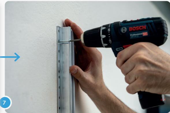
7 Jetzt kannst du die Schienen mit mind. vier Schrauben (nicht im Lieferumfang enthalten) pro Schiene montieren. Zwei Schrauben oben...
