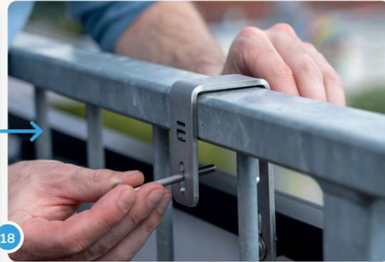
...dann die langen Schrauben unterhalb des Handlaufs durchstecken...
