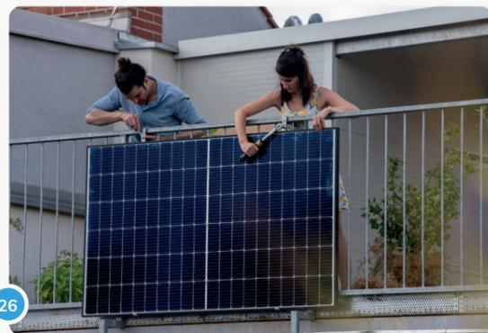
Jetzt kannst du ein noch einmal alle Schrauben kontrollieren und bei Bedarf fester anziehen...
